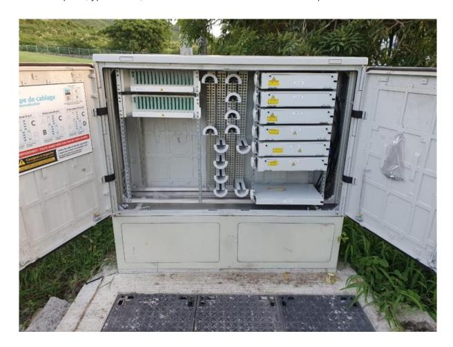
Le schéma ci-dessus présente l'aménagement typique d'une armoire de rue PM avec 2 espaces 19 pouces droit et gauche équipés respectivement des tiroirs Clients Finals et des tiroirs coupleurs des Opérateurs Commerciaux.
